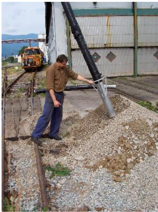
Odstraňovanie štrkovitých a zrnovitých materiálov
